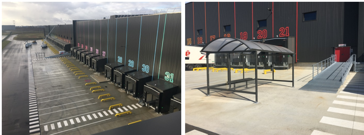
Figure 7 : exemple de façade ITM – vues générale et rapprochée
